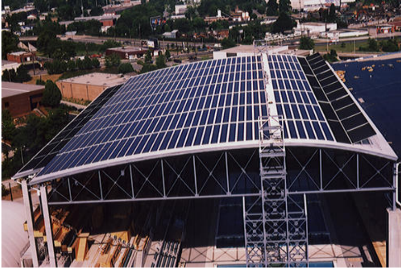
Şebekeyle bütünleşik güneş pili panelleri
